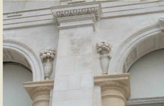
Mise en oeuvre renaissance en tuffeau (Château-neuf)
