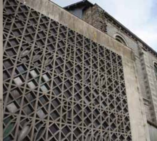
Agrandissement contemporain en béton
