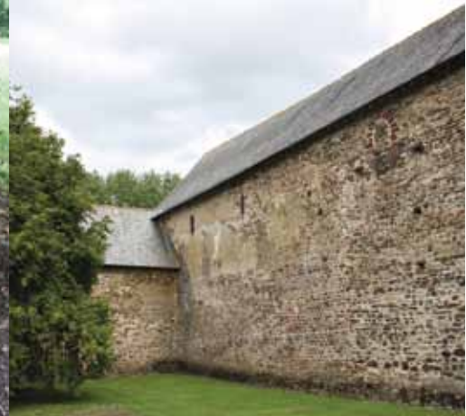
Mur nord de la nef
