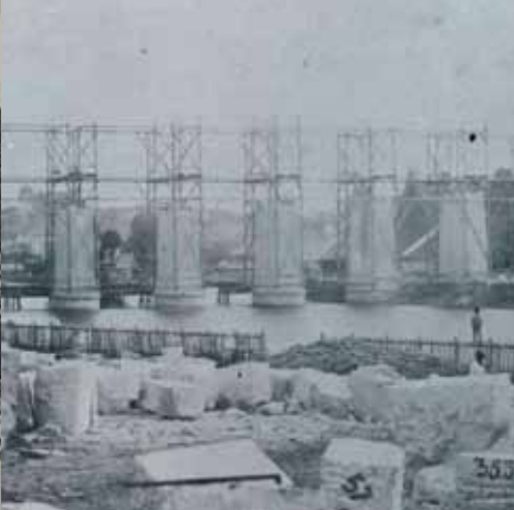
Le viaduc en construction au printemps 1855 (AD Mayenne)
