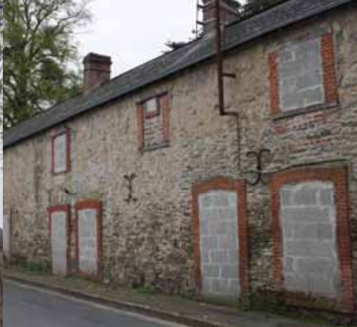
Ancienne barre de logements ouvriers, rue du Frêne
