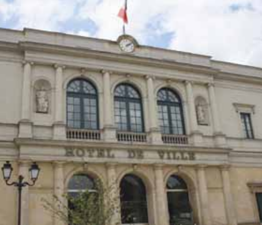
Façade de l'Hôtel de Ville
