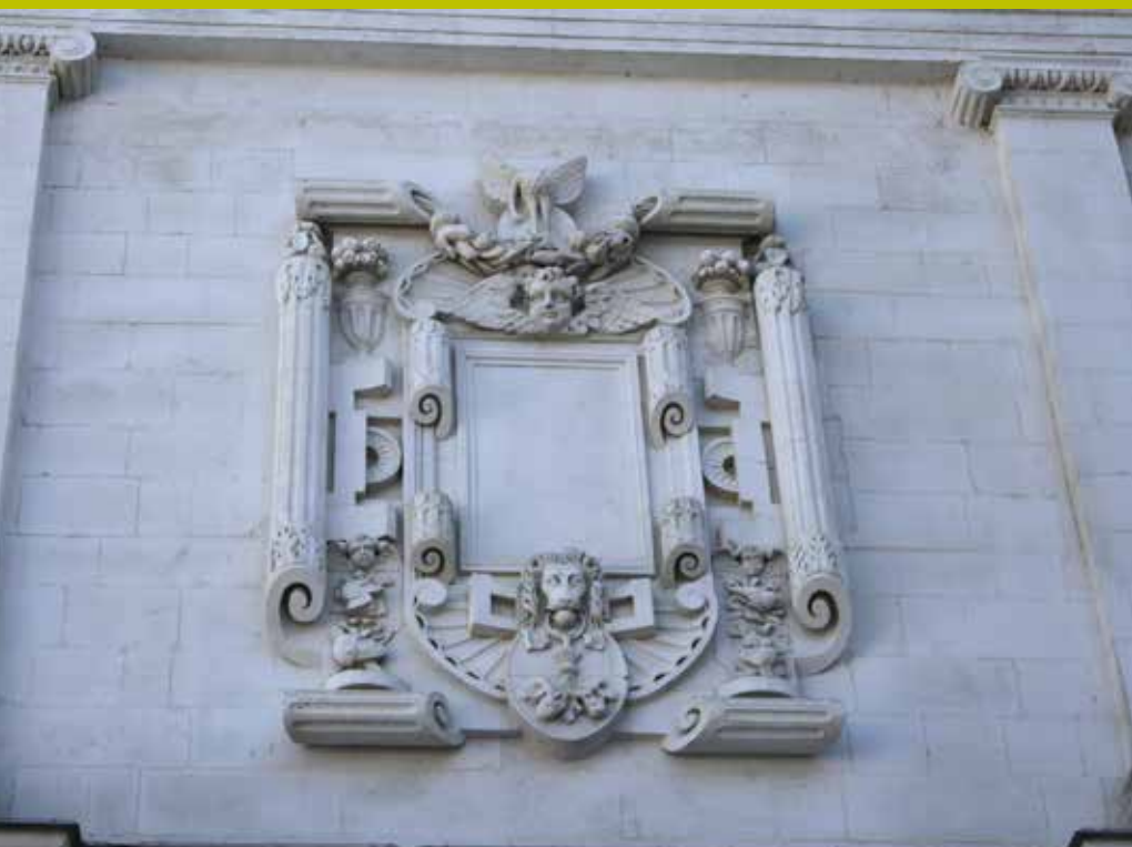
2 - Frise et décor sculpté ornant la partie haute des arcades du rez-de-chaussée de la galerie
